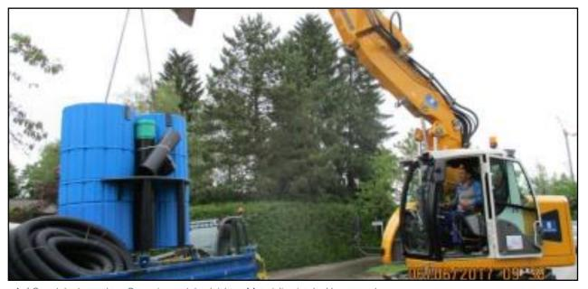
Auf Grund der kompakten Bauweise und den leichten Materialien ist das Versetzen des Systems mit einem Baustellengerät möglich, welches auf jeder Tiefbaustelle vorhanden ist.
