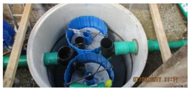
Eingesetzte Behandlungsanlage **Hydrosystem heavy traffic** in der Zwillingsversion. Zulauf rechts im Bild, Ablauf entsprechend links, wobei die Winkelverhältnisse variabel sind.
