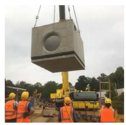
Ca. 45 Tonnen wiegt das Drosselbauwerk, das für einen geregelten Abfluss der Niederschläge sorgt. Foto: Max Bögl
